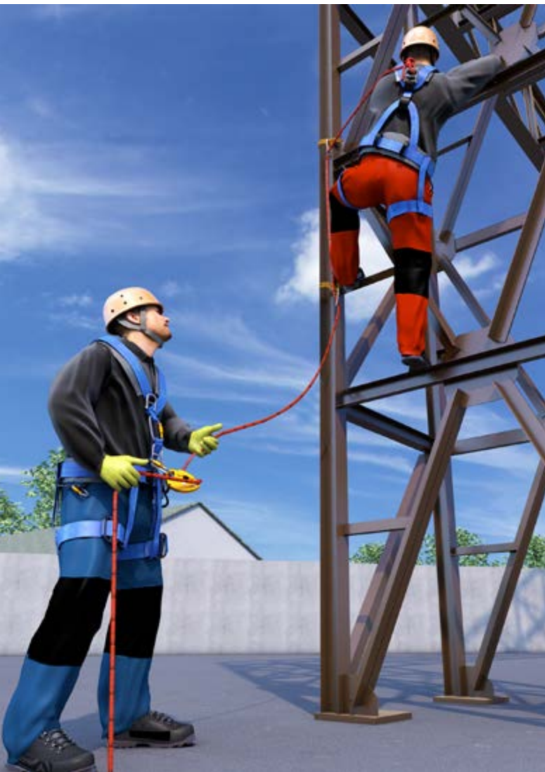
Abb. 13 Vorstieg an einer Rohrbrücke
