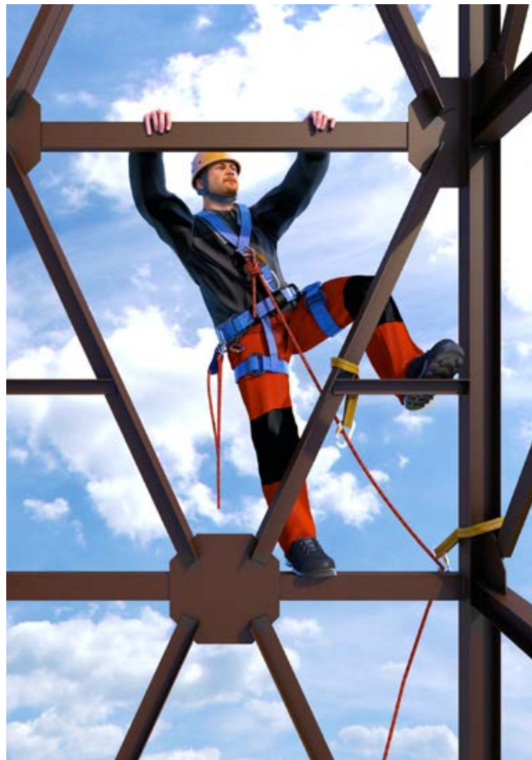
Abb. 14 Vorstieg an einer Rohrbrücke
